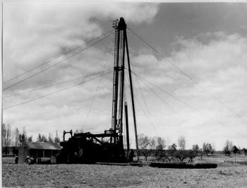
Sondeo en Ceriliana con equipo perforador a percusión
