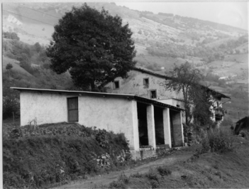
Estercolero cubierto en Regil (Guipúzcoa). — Obra auxiliada por Colonización Local.
