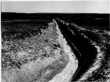
Desagüe secundario — Primer tramo del Canal de Monegros (Huesca). Se han construido 1.268 km. de desagües en la Delegación del Ebro.
