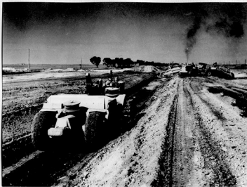
Construcción de acequias en tierra por los equipos mecánicos del Parque de Maquinaria Agrícola del I. N. C. — Zona de Bardenas (Zaragoza).
