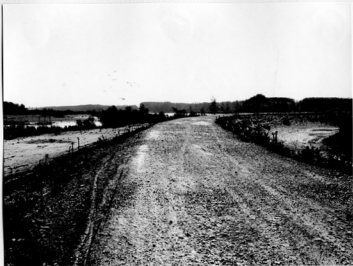
Dique de defensa en la orilla del río Ebro construido por el Parque de Maquinaria Agrícola, como consecuencia de la riada del año 1960.
