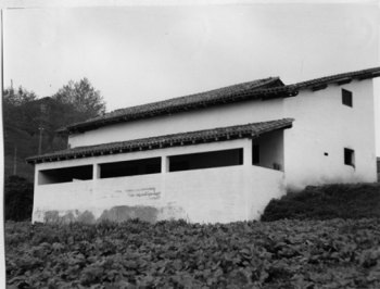
Estercolero cubierto en Oyarsun (Guipúzcoa). — Obra auxiliada por Colonización Local.
