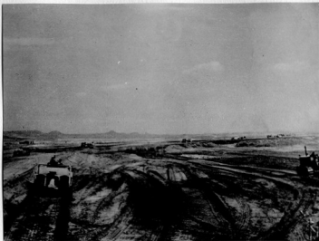
Trabajos de nivelación en la zona del Canal de Manegros (segunda tramo).
