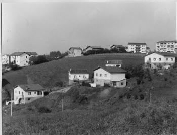
Grupo de cinco viviendas en Huertos Familiares del I. N. C. en San Sebastián (Guipúzcoa). — Obra auxiliada por Colonización Local.
